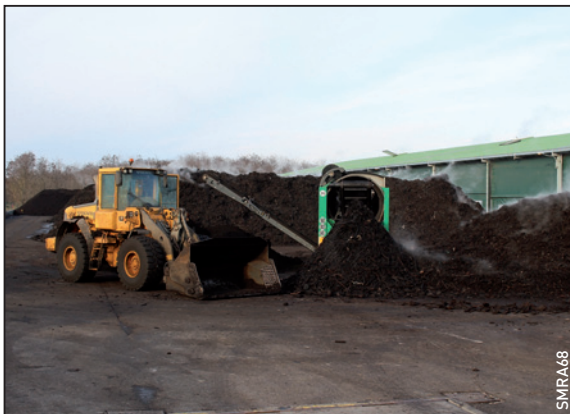
Plateforme de compostage des boues
