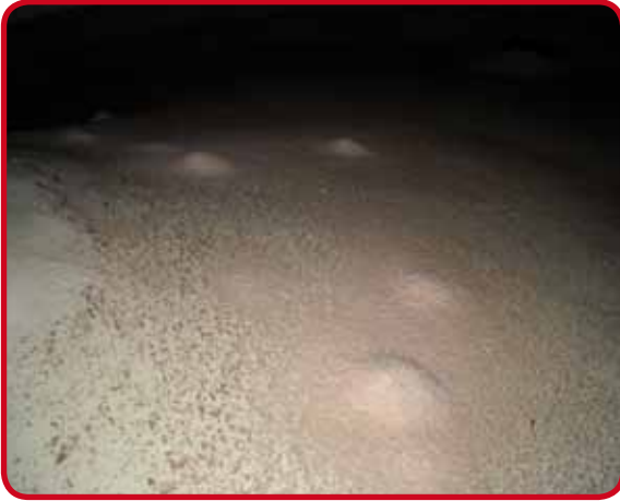
Cloques sur le cône de fond
