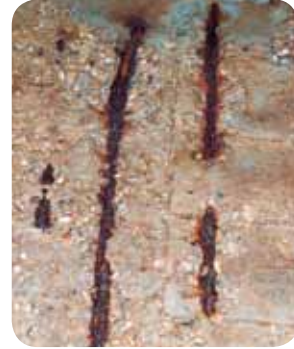
Poutrelle érodée, armature à nu
