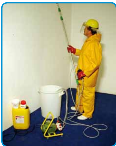
Pulvérisation basse pression : pulvérisateur électrique, lance télescopique, bac de mélange. Bottes, gants, casque, protection du visage et du corps contre les projections.
