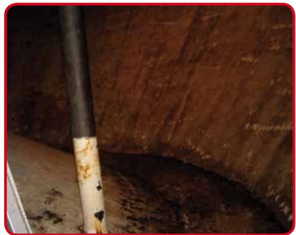
Revêtement époxy, photo B
