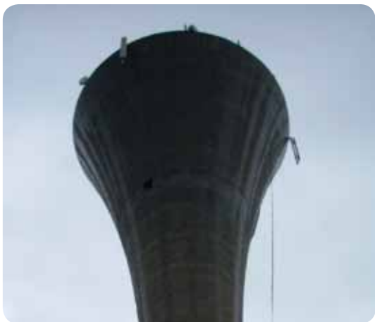
Réservoir sur tour
