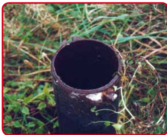
Cheminée d'aération sans son chapeau
