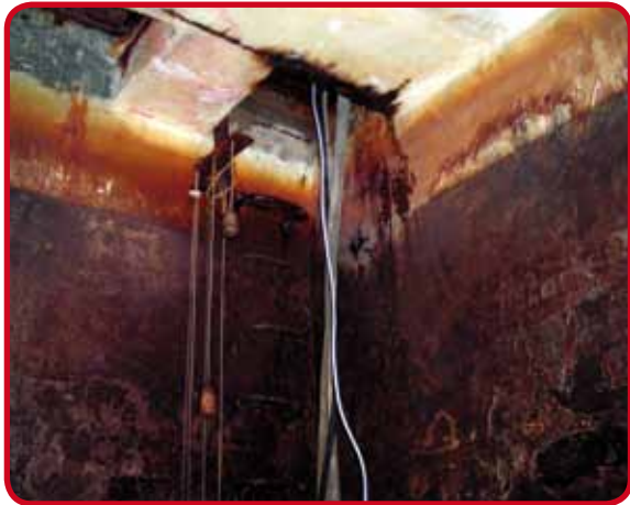
Dépôts fer - manganèse, photo C
