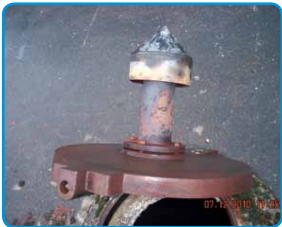
Capot-regard avec cheminée d'aération Fonctionnel et sécurisé
