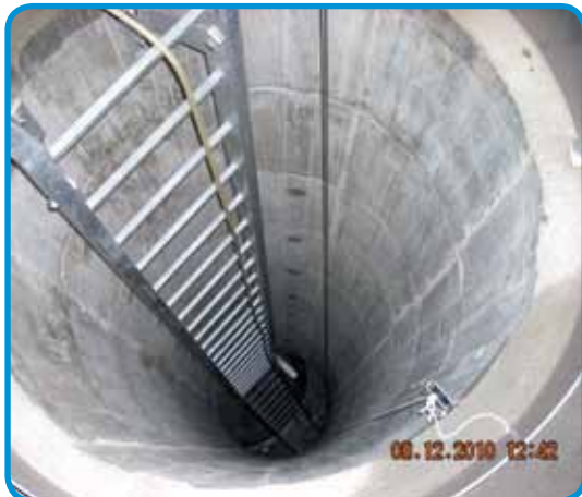
Sécurisation d'un ouvrage de grande hauteur
