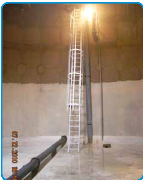
Revêtement béton et enduit
