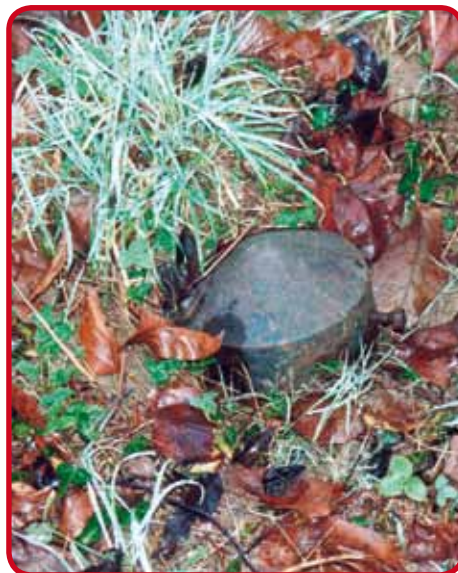
Cheminée d'aération enterrée
