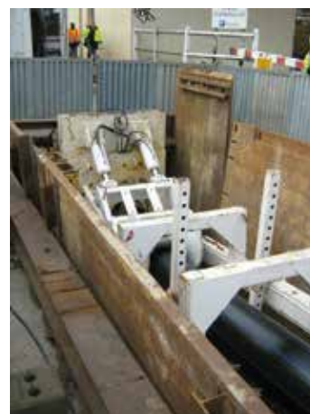
Tubage sans espace annulaire: puits d'introduction (source : Grand Lyon)
