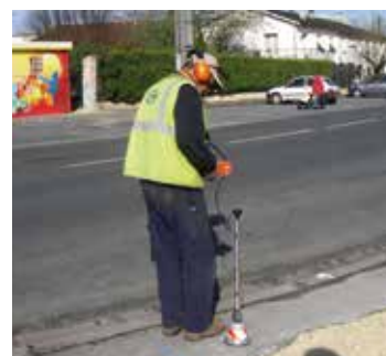
Réalisation d'une écoute au sol (source : Irstea)
