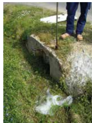
Réalisation d'une purge (source : Irstea)
