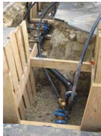
Remplacement d'une canalisation en tranchée ouverte (source : SEDIF)
