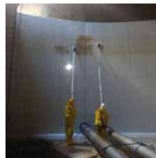
Lavage d'un réservoir (source : Herli)
