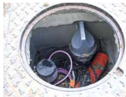
Dispositif de télégestion (source : Sofrel)
