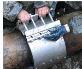
Installation d'un manchon de réparation (source : Norham)
