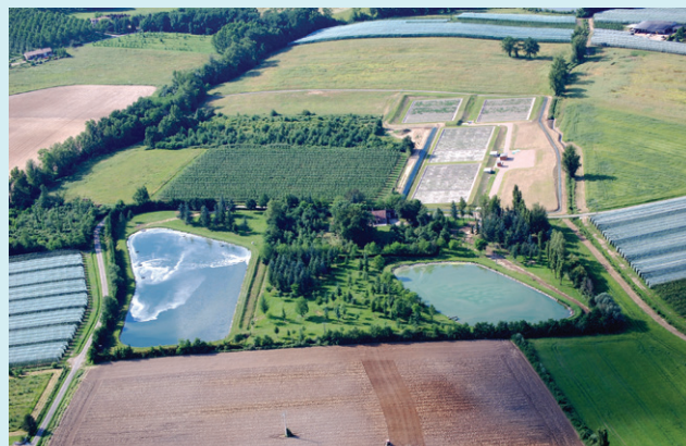
VUE AÉRIENNE DE LA STATION : EN HAUT, LES 2 LAGUNES, EN BAS À GAUCHE, LES 2 ÉTAGES DE FILTRES
