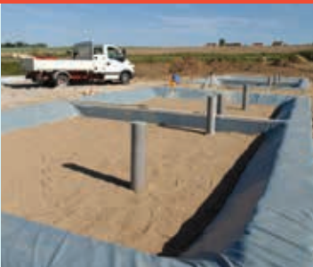
1. TERRASSEMENT DES BASSINS
