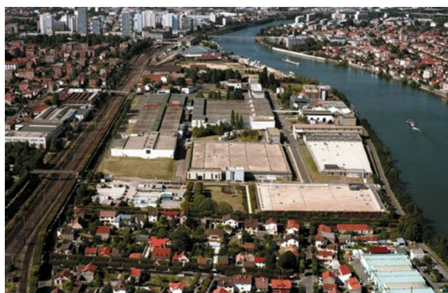
Usine d'eau potable de Choisy-le-Roi au cœur de l'Île de France urbanisée
