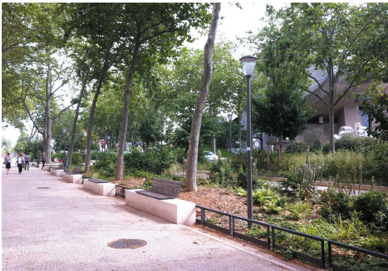
Projet Ville Perméable. Réaménagement de la rue Garibaldi à Lyon : collecte des eaux pluviales par des noues végétalisées, puis stockage dans un bassin enterré avant réutilisation. Juin 2016
