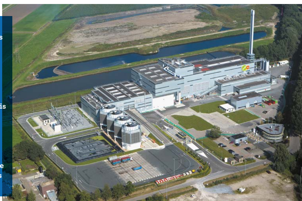
ReEnergy, usine de valorisation énergétique de Roosendaal (Pays-Bas) © Suez
