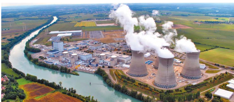
Centrale nucléaire de production d'électricité de Bugey (au premier plan, la zone de pompage dans le Rhône pour le refroidissement des deux tranches de gauche en circuit ouvert)
