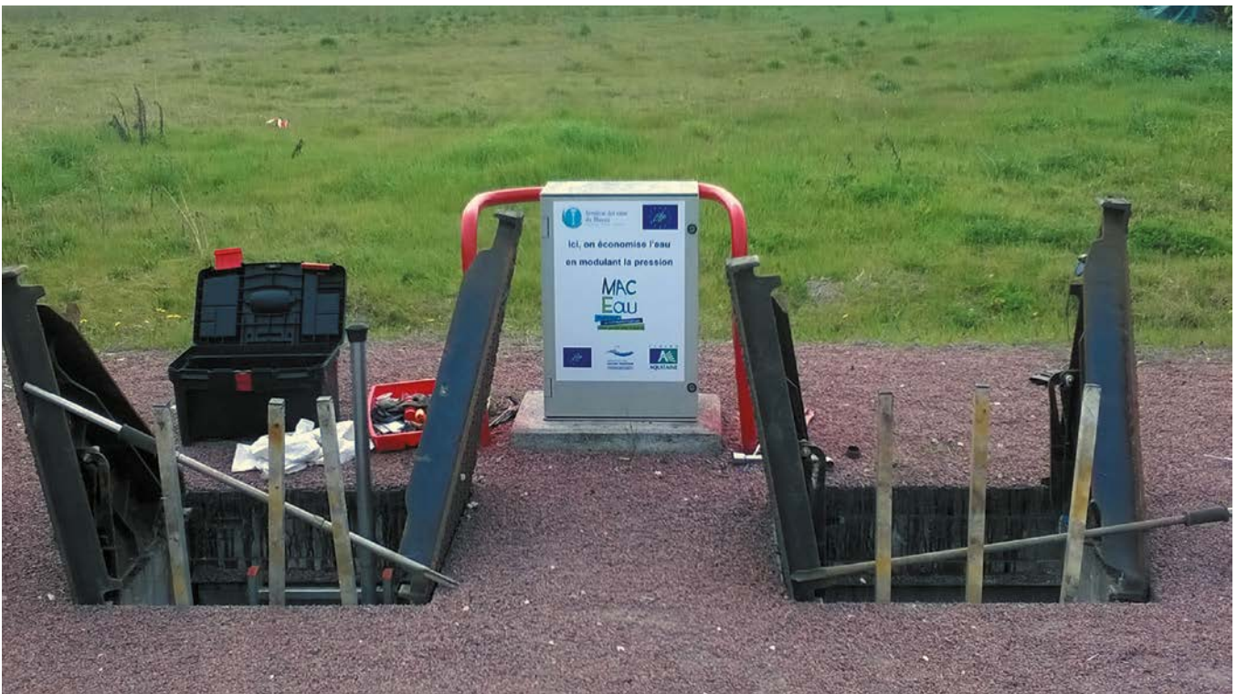
Regard pour l'emplacement des modulateurs de pression dans le cadre du projet MAC Eau
