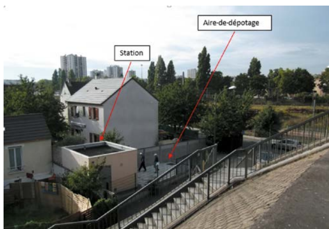
Station de chloration à l'eau de javel à Argenteuil (Val d'Oise). Terrain (bâtiment + aire de dépotage) difficile à trouver en zone urbanisée d'Île de France
