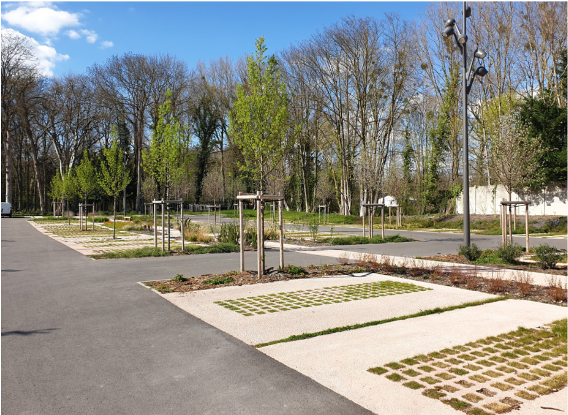
Parking filtrant rue Pinto à Cormontreuil. Source : Grand Reims.
