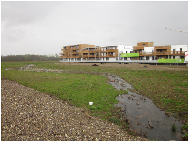
Écoquartier labellisé des Bohries
