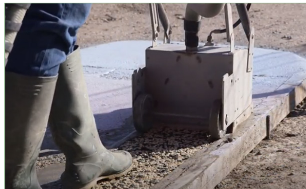
Figure 27 : Dispositif pour décolmater le revêtement perméable. Source : Adopta.
