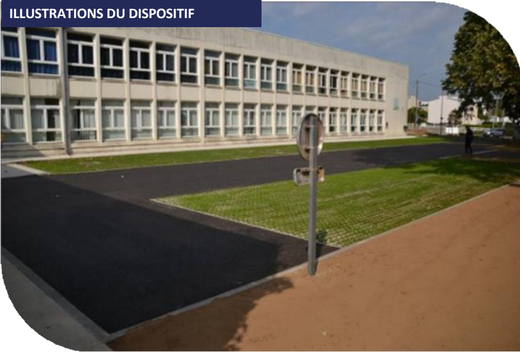
Figure 2 : Parking Dukas - Massifs d'infiltration avec revêtement perméable
