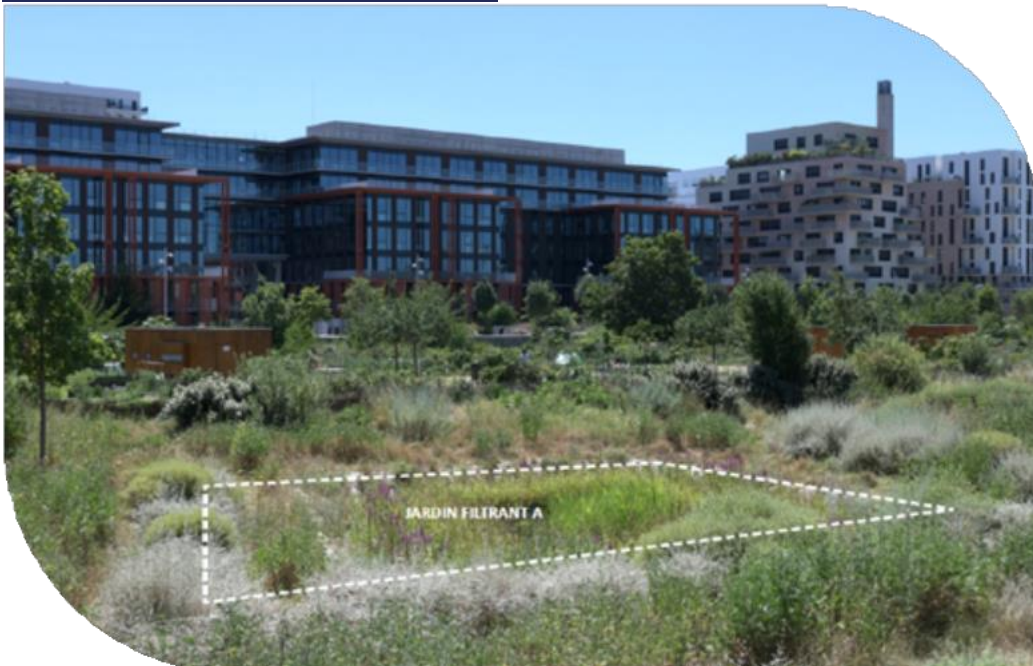
Figure 1 : Jardin filtrant avec étanchéité en géomembrane (secteur 2)
