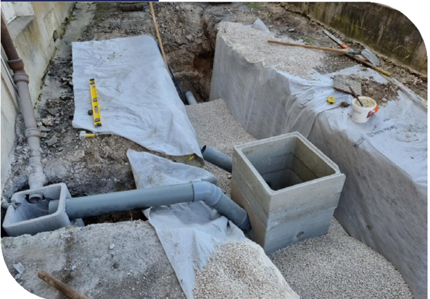
Figure 1 : Détail d'un regard d'injection et cloisonnement
