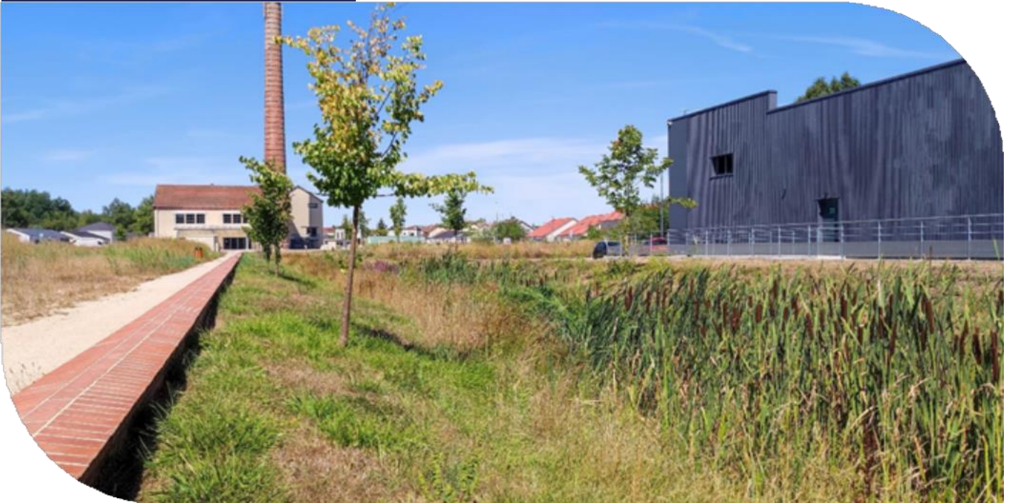
Figure 3 : Ouvrages de gestion intégrée des eaux pluviales
