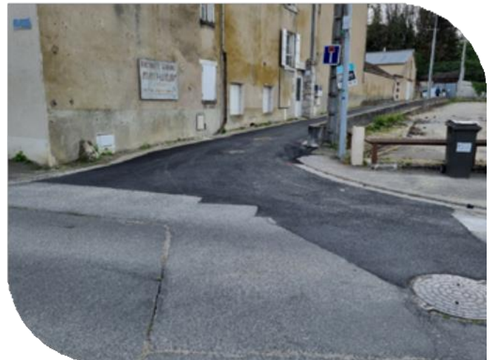
Figure 4 : Le contexte urbain se prête d'avantage à un traitement minéral en tranchée drainante - Après : déconnexion de 1000 m 2
