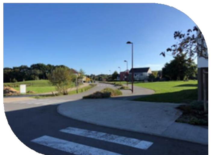
Figure 3 : Espaces verts inondables de la ZAC de l'Isle au Bois
