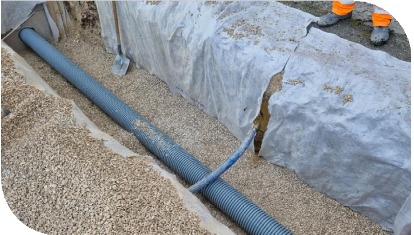
Figure 2 : Mise en place du drain dans la tranchée
