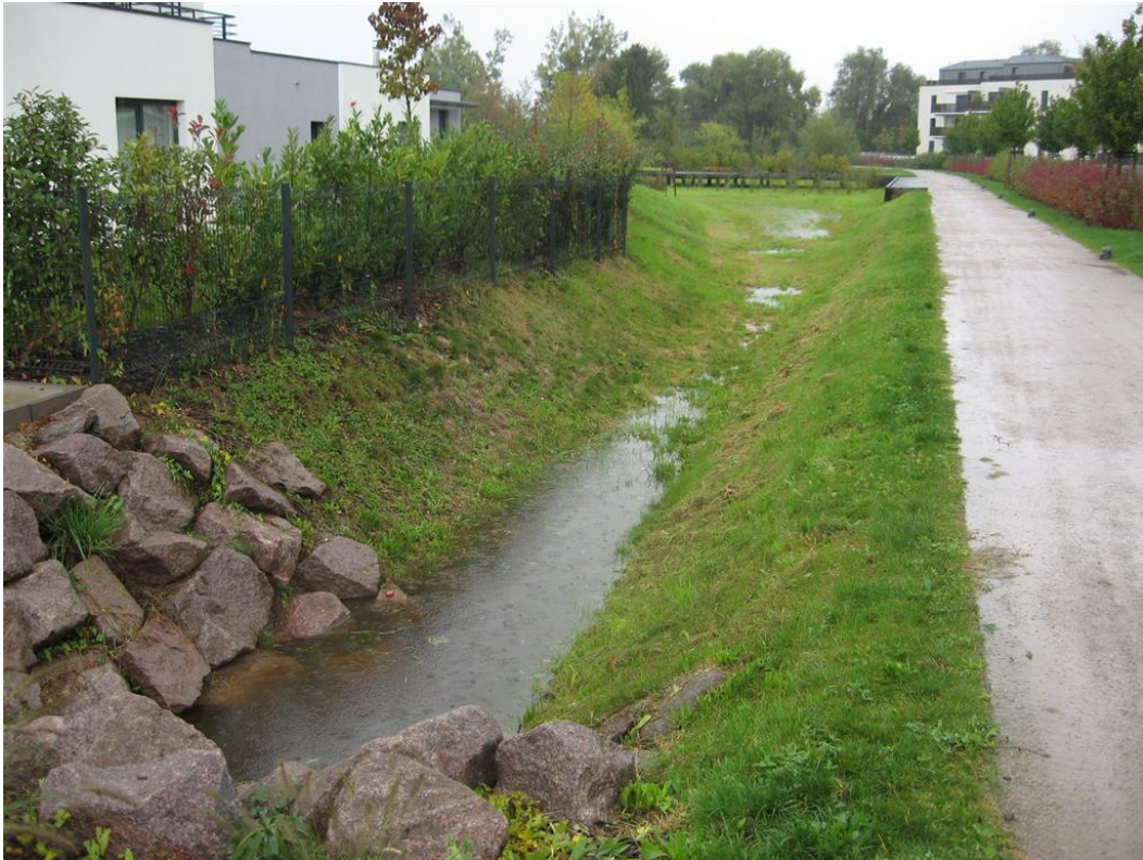
Figure 5 : Vue depuis la rue Alfred Timmesch
