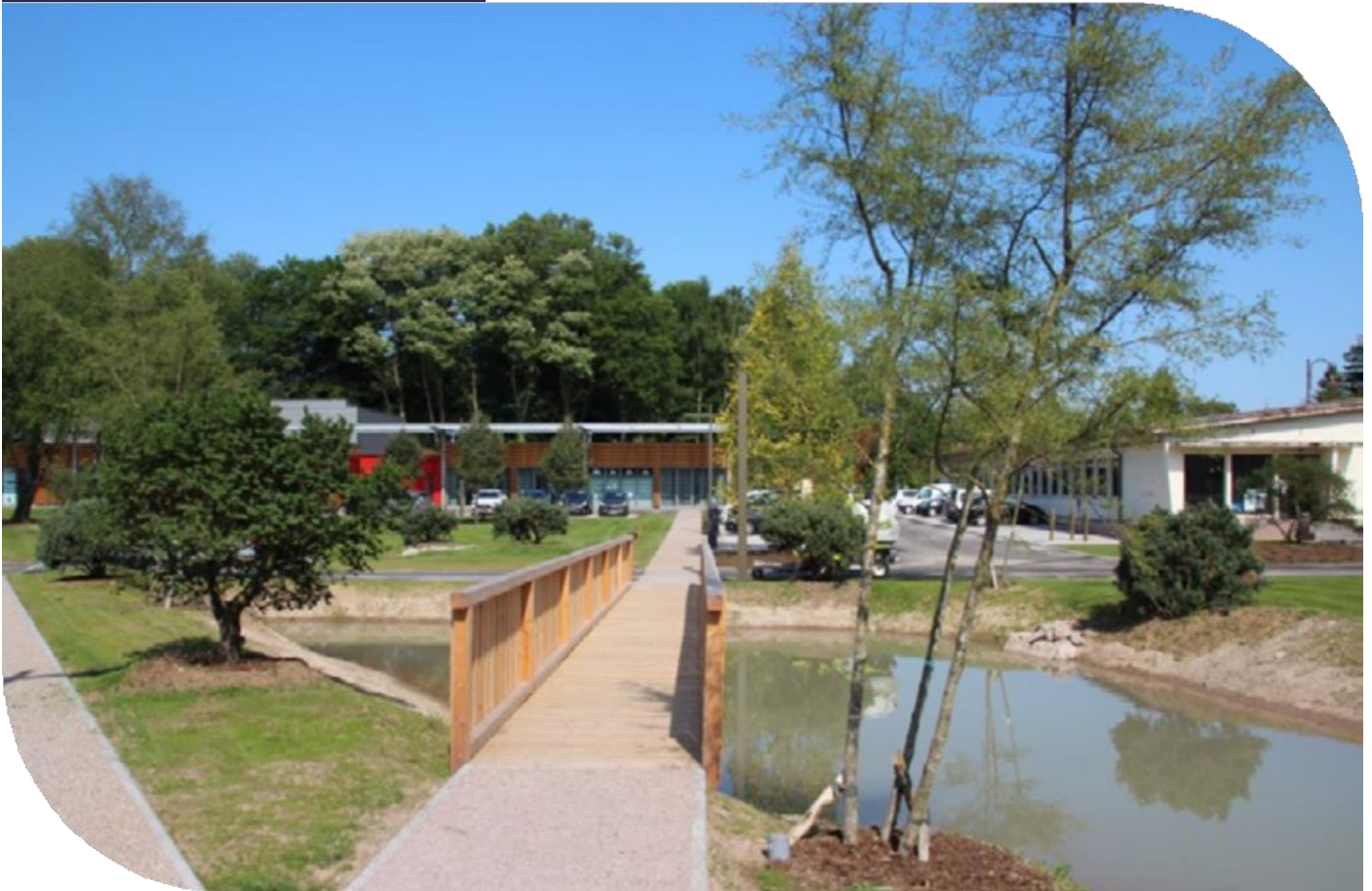
Figure 2 : Parkings du pôle administratif et de l'hôtel d'entreprises (vue du sol)
