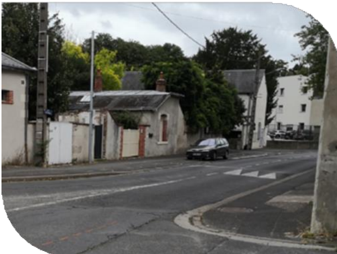
Figure 3 : Le contexte urbain se prête d'avantage à un traitement minéral en tranchée drainante - Avant : rejet du pluvial au réseau unitaire
