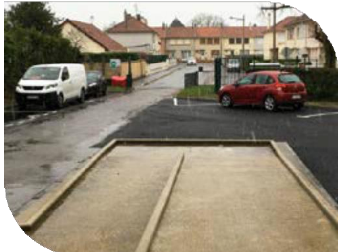
Figure 2 : Parking non drainé à gauche et drainé à droite
