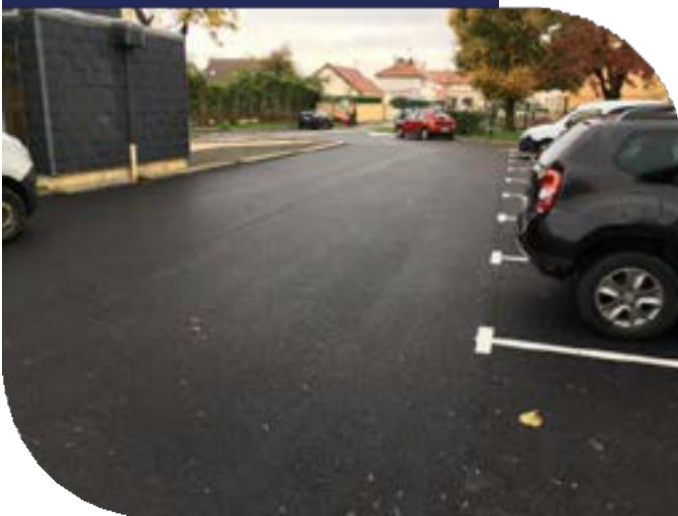
Figure 1 : Parking en chaussée drainante
