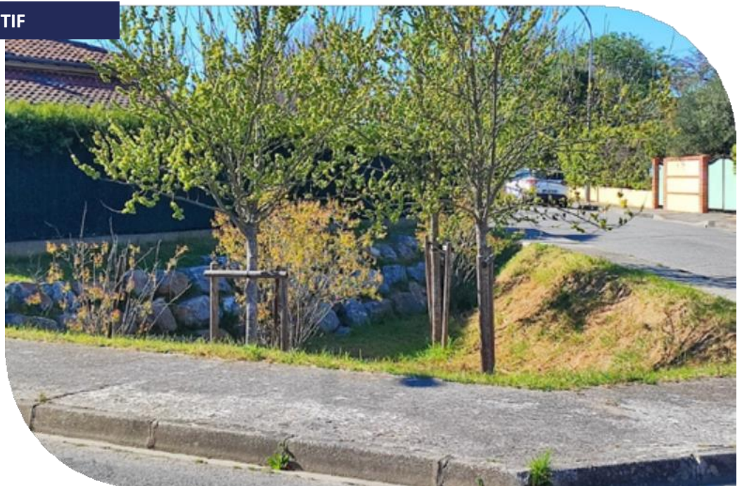
Figure 1 : Bassin de rétention et d'infiltration des eaux pluviales de la ville du Portet-sur-Garonne
