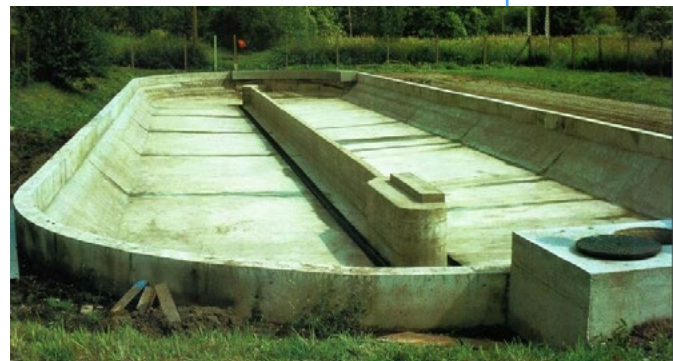
Photographie d'un bassin d'orage Source : FNDAE
