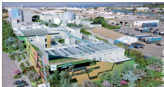
Figure 2. Station d'épuration de Sète, contrat Suez avec garantie microplastiques
